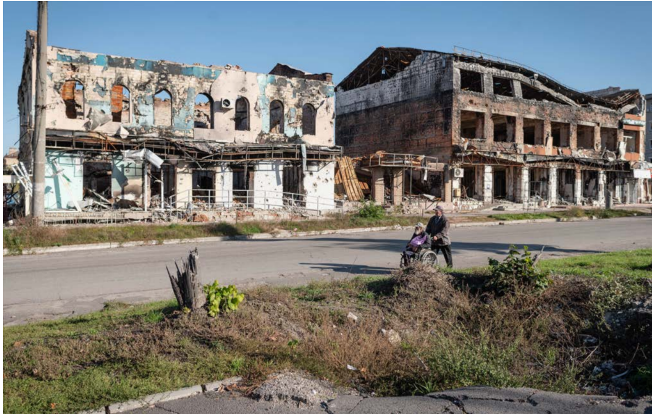
^ Куди не глянеш — всюди смуток і біль: у зруйнованих будівлях, понівечених дорогах, на обличчях людей
