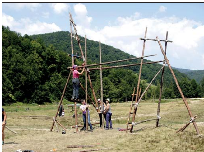
Будівництво брами «Школи булавних»
