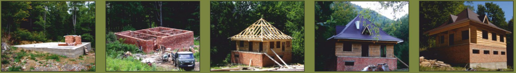
Командний та господарський курінь: від фундаменту до будівлі
